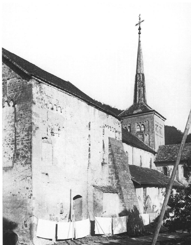
Fig. 1 Vue d'ensemble de l'église en 1898, une année avant que ne débute la restauration Naef-Châtelain-Correvon. Les façades portent encore leur crépis et la présence de linge séchant dans le pré témoigne de la décadence de l'ancienne abbatiale, reléguée peu à peu au rang d'église paroissiale de village.
