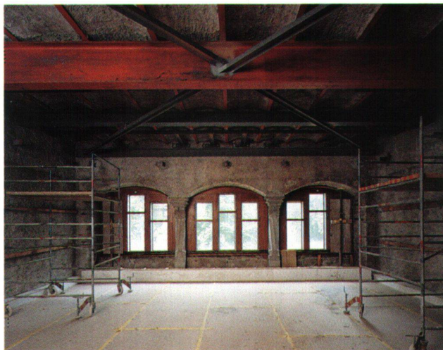
Abb. 3 Ausbau der Ratsstube von Mellingen im Zuge der ersten Probesanierungen im Westflügel, Sommer 2005.
