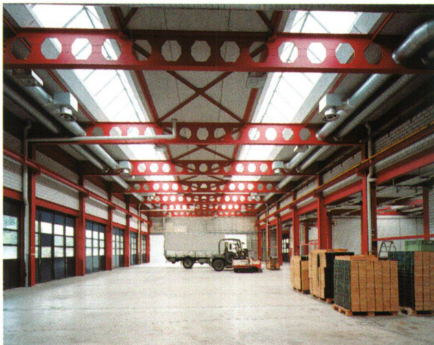
Abb. 2 Sammlungszentrum Affoltern am Albis, Kanton Zürich. Innenaufnahme, grosse Halle vor dem Umbau, Juli 2005.
