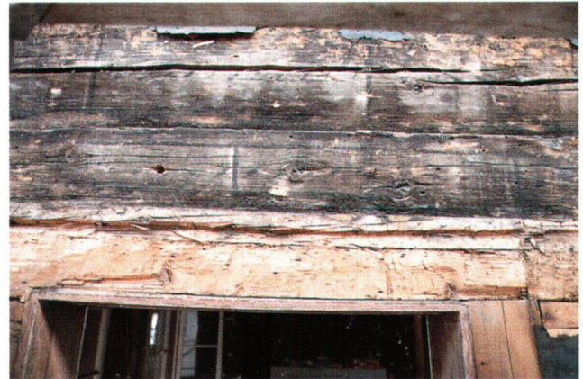
Abb. 18 Menzingen, Hauptstrasse 6: Reste der Quaderimitation an der Südfassade über dem ersten Obergeschoss. Darunter die fassadensichtigen Bretter der Decke über dem ersten Obergeschoss. Blick nach Norden.
