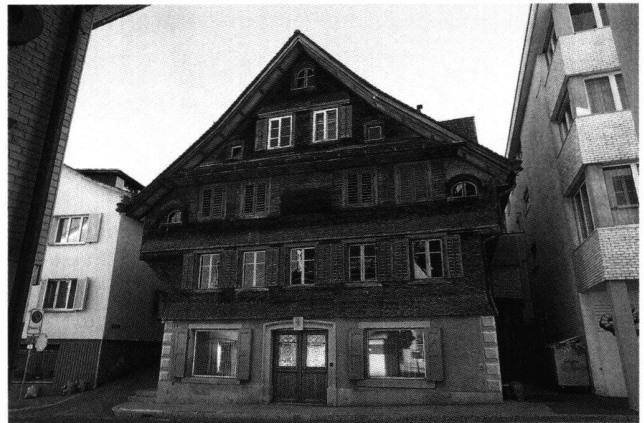
Abb. 1 Die Südfassade (Gassenseite) des Hauses Hauptstrasse 6 in Menzingen vor dem Umbau 2004. Blick nach Norden.
