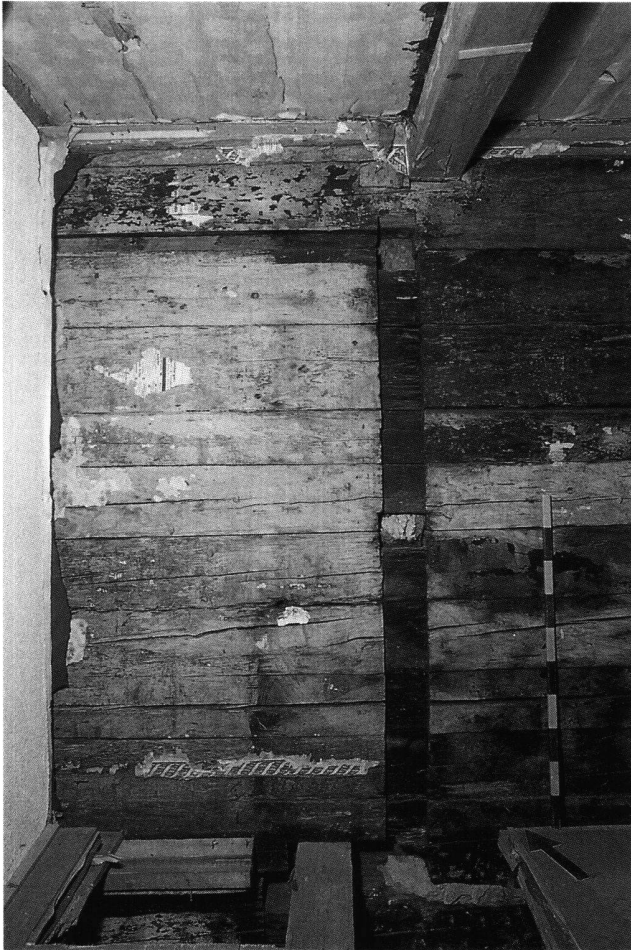
Abb.9 Menzingen, Hauptstrasse 6: Nordwand des zweiten Obergeschosses von innen. Die abgebrochene Ostwand der Kammer links war mit einer Nut und nur drei einzelnen Blockvorstössen (zuoberst, in der Mitte und zuunterst) mit der Nordwand verbunden. Blick nach Norden.
