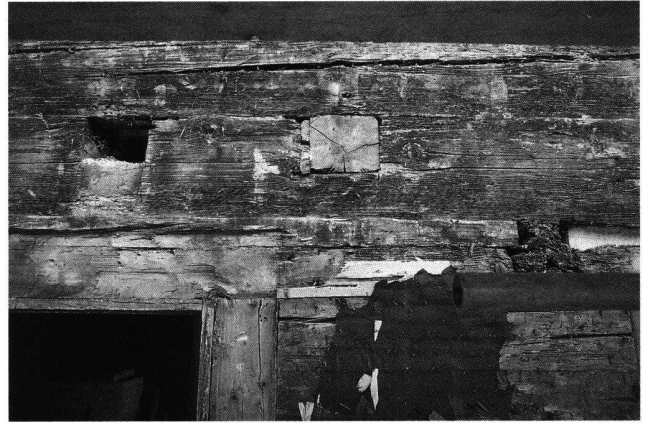
Abb.10 Menzingen, Hauptstrasse 6: Südfassade mit den «fassadensichtigen» Deckenbrettern des ersten Obergeschosses und dem abgesägten Vorstoss des obersten Balkens der Trennwand zwischen den beiden Kammern des ersten Obergeschosses. Darüber links der ebenfalls abgesägte unterste Vorstoss der Trennwand der Kammern des zweiten Obergeschosses. Blick nach Norden.
