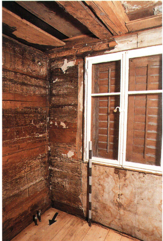
Abb. 12 Menzingen, Hauptstrasse 6: Die Südostecke der Stube im ersten Obergeschoss, Blick nach Südosten. An der Trennwand zur kleinen Kammer links Reste von Bemalung, insbesondere von Quaderimitation (unten). An der Südwand rechts abgesägte Deckenbretter (oben).
