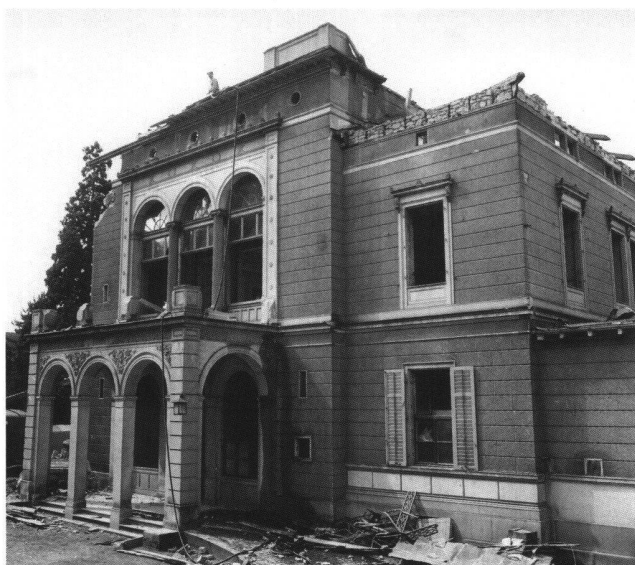
Abb. 9 Villa Seeburg während der Abbucharbeiten. Aufnahme 29. Juli 1970.
