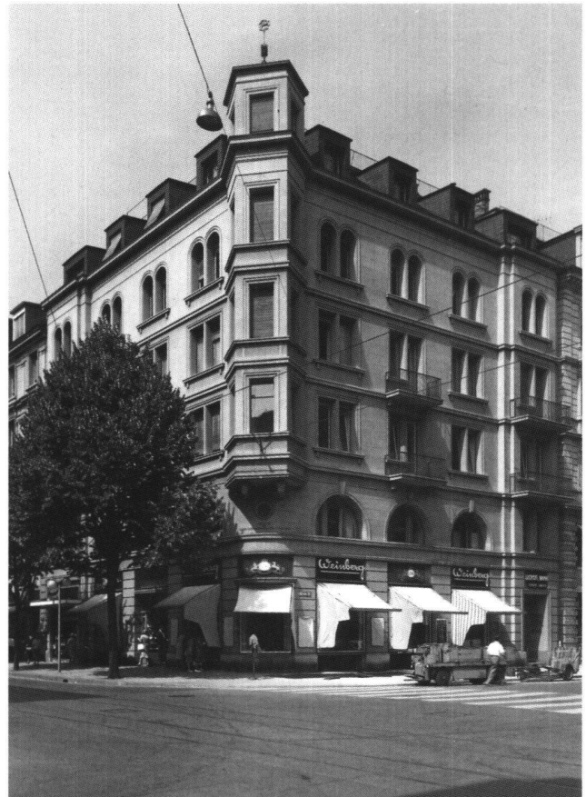
Abb. 3 Dasselbe Gebäude nach der Purifizierung um 1951–1952. Purifizierungen waren in Zürich seltener und erfolgten später als in Berlin. Aufnahme 1964.
