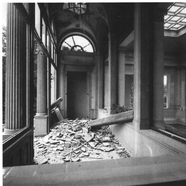
Abb. 10 Villa Seeburg, Treppenhalle beim Abbruch. Aufnahme 29. Juli 1970.
