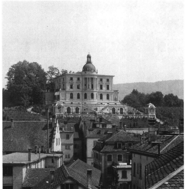
Abb. 23 Villa Wegmann auf der Hohen Promenade. Der Baukörper dominiert die Stadtsilhouette. Aufnahme 1890.
