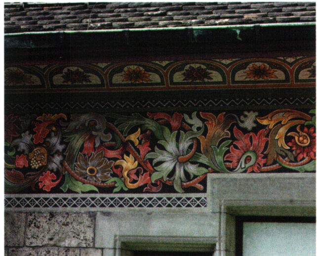
Abb. 19 Schweizerisches Landesmuseum Zürich. Rankenfries an der Aussenfassade des ehemaligen Kunstgewerbeschulflügels, von Christian Schmidt, 1897, gemalt mit Keims Mineralfarben.
