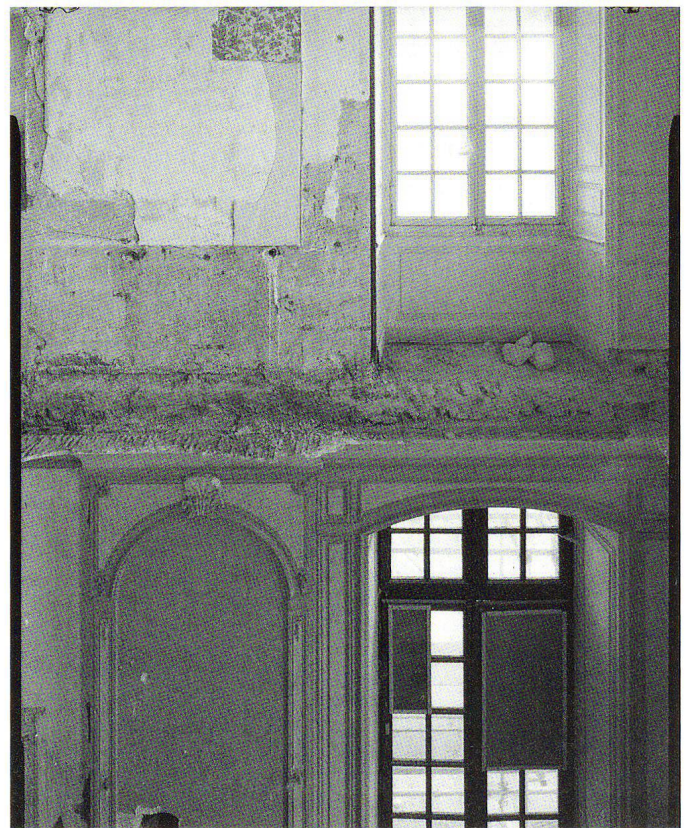
Fig. 8 Vue d'intérieur du Château de Prangins en travaux (salles 1029 et 1108), 1991. Photographie de Jean-Marc Yersin.
