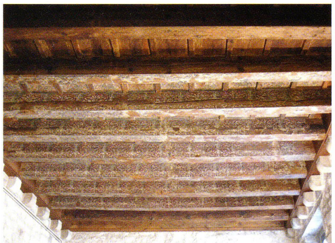
Fig. 14 L'ensemble après la restauration.
