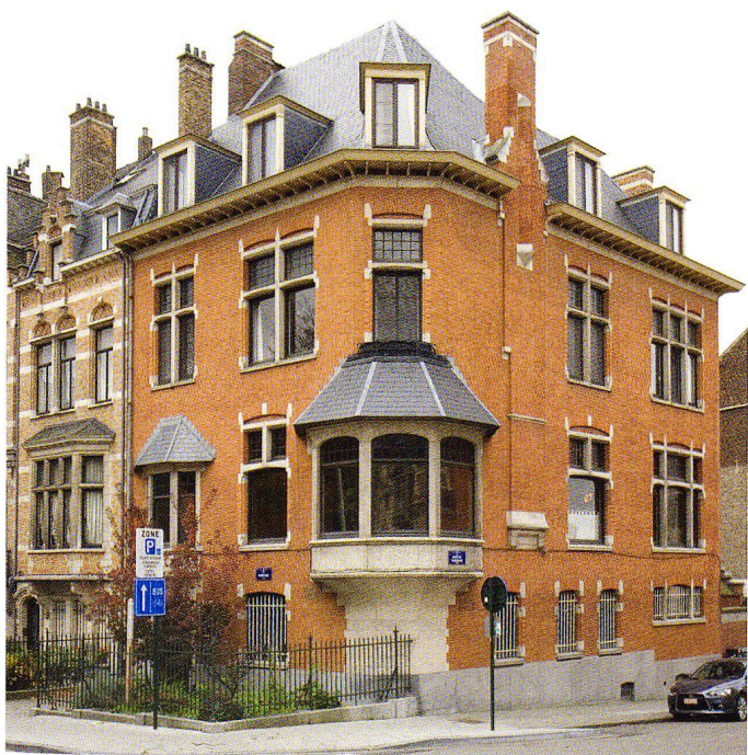
Fig. 1 Maison de l'agent de change Julien Van Stappen, communément appelée Quaker House, réalisée par l'architecte Georges Hobé en 1899.
