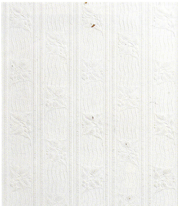
Fig. 6 Papier peint original (surpeint en blanc) recouvrant le bas des murs de la cage d'escalier.
