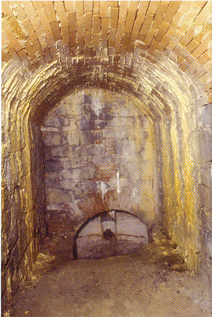
Abb. 18 Latrinestollen. Hinterster Teil mit Fäkaliengrube.
