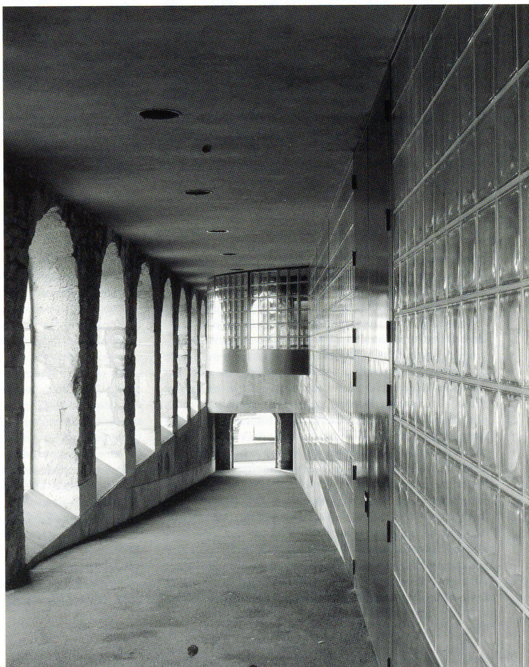
Fig.2 L'ancien abattoir de Fribourg transformé en annexe du Musée d'art et d'histoire : vue actuelle du passage piétonnier créé derrière les arcades du rez-de-chaussée.
