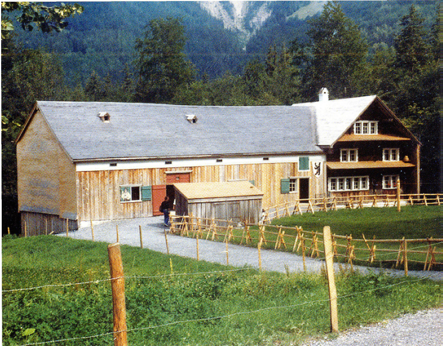
Abb.38 Haus Blülisau im heutigen Zustand.
