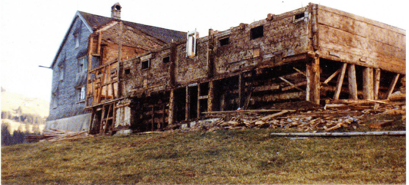
Abb.35 Haus Brülisau während der Demontage, um 1984.
