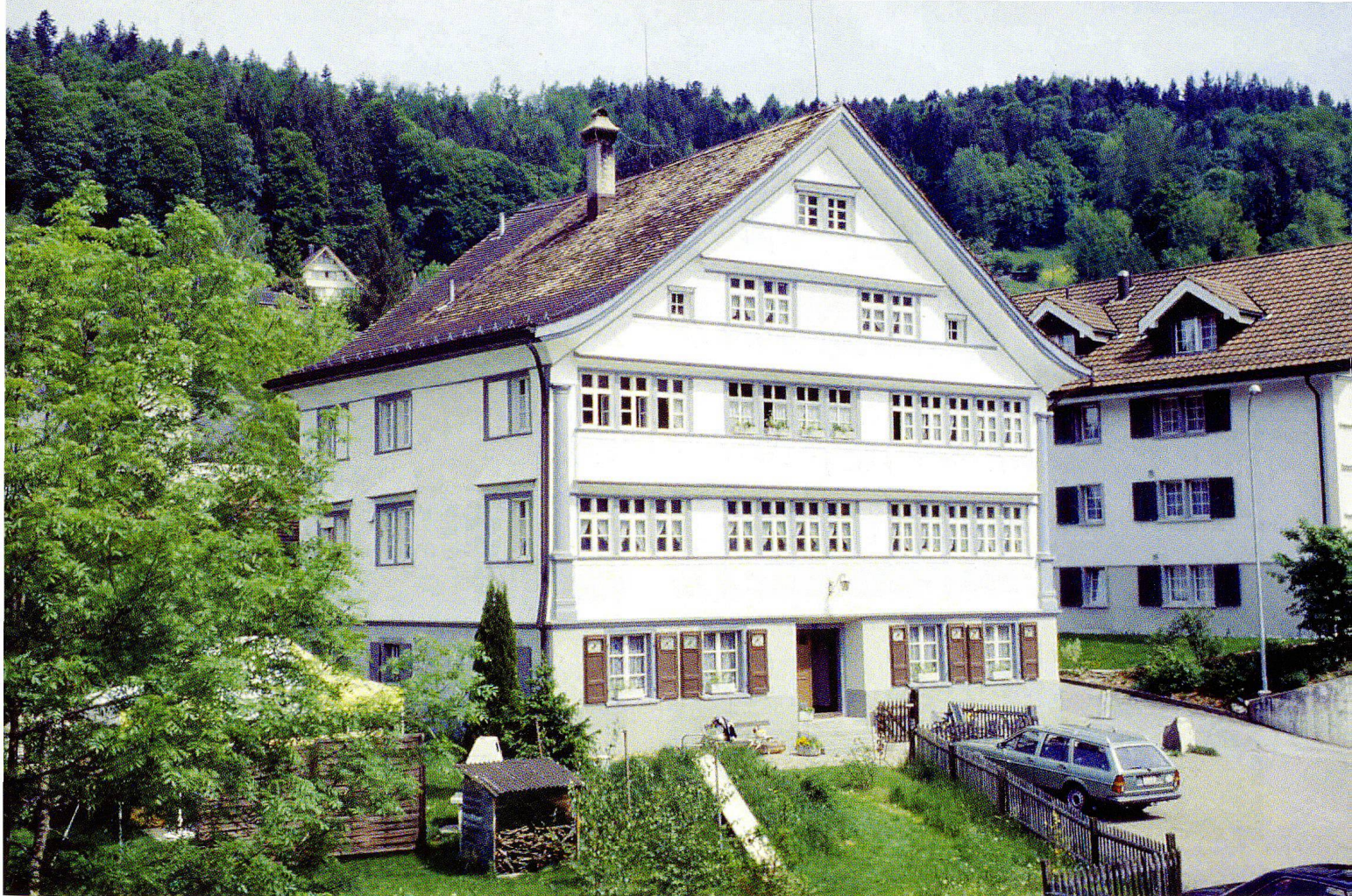
Abb. 15 Das versetzte Rathaus von Trogen in seinem heutigen translozierten Zustand in Bühler.
