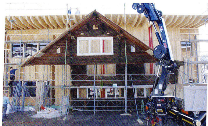
Abb.44–47 Demontage des Hauses Egger in Unterwolfhalden und Translozierung der Bauteile zur Werkhalle des Holzbetriebes Nägeli nach Gais.
