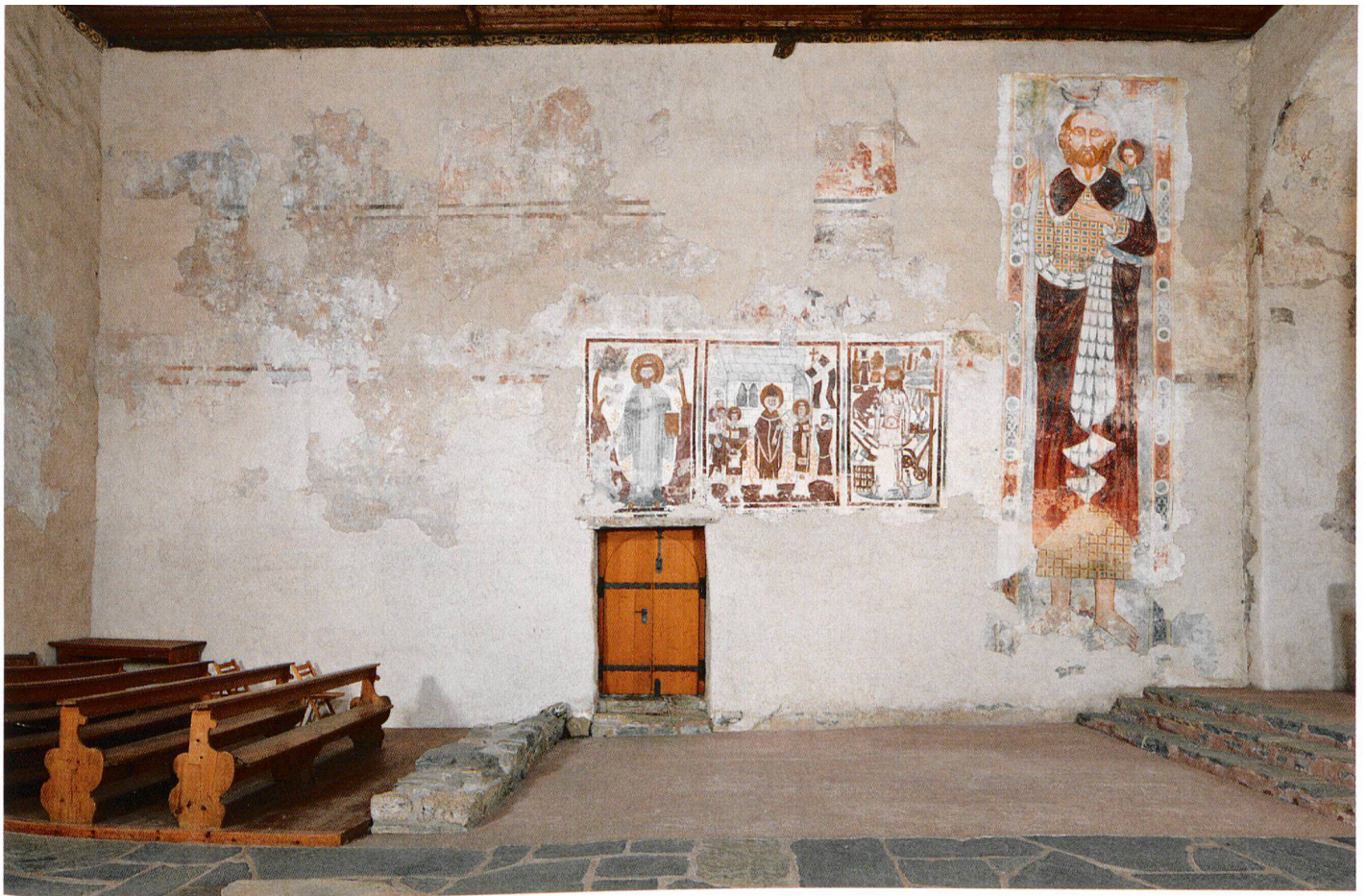
Abb. 7 Mistail, Nordwand. Die horizontalen Bänder liegen unter der gotischen Malerei.
