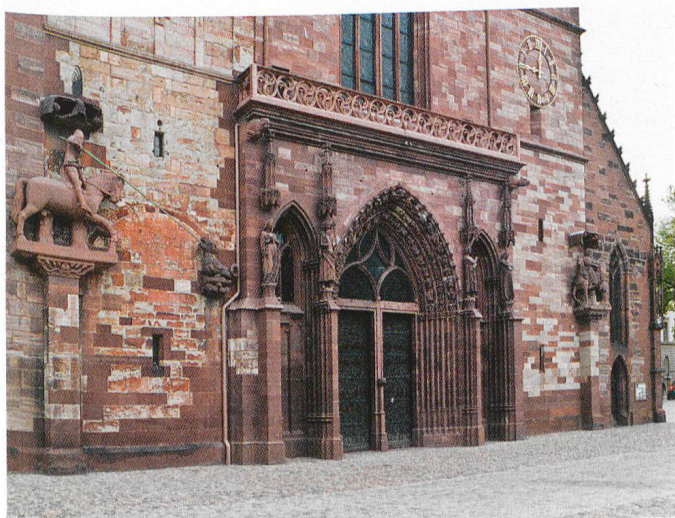
Abb. 2 Ausschnitt der Westfassade mit Hauptportal.
