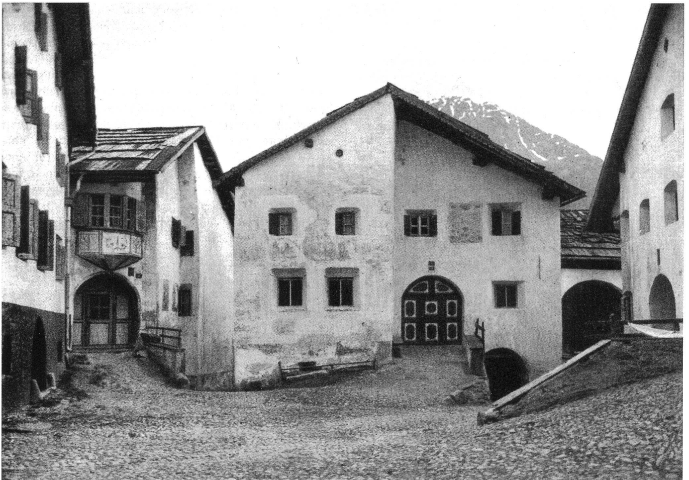
Abb.10,11 Guarda GR, der Dorfplatz vor und nach der Restaurierung durch Iachen Ulrich Könz (1939 bis 1945), Aufnahmen um 1941.
