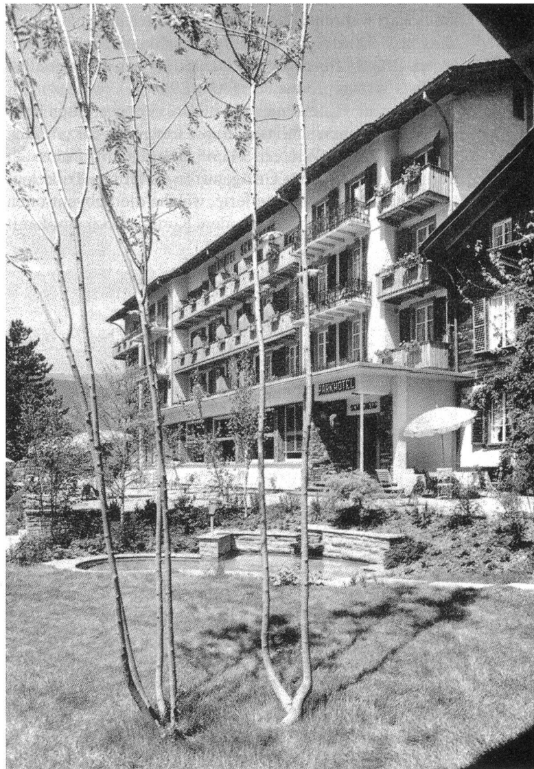
Abb. 21, 22 Grindelwald BE, das «Parkhotel» in Grindelwald vor (oben) und nach der Umgestaltung gemäss Projekt der Bauabteilung des Hotelierversains, um 1955.
