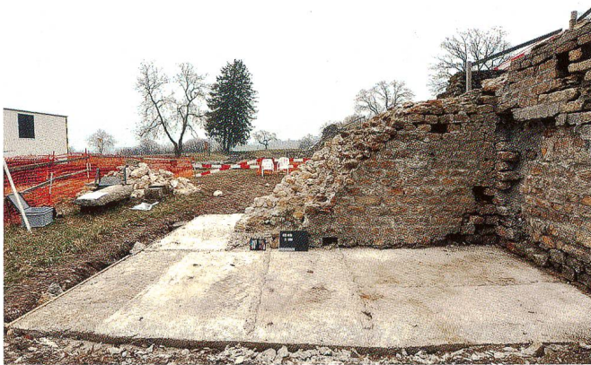
Abb. 13 Aventicum/Avenches (VD), théâtre romain. Aditus sud-ouest, fondation à la base du mur M90, négatifs des blocs en gros appareil, travaux en cours, 2013.
