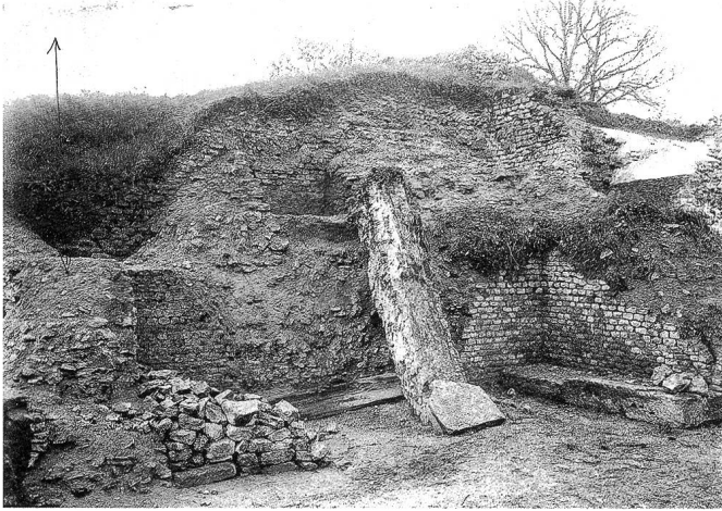
Abb.2 Aventicum/Avenches (VD), römisches Theater. Südwest-Aditus während der Freileigungsarbeiten im Jahre 1898. Deutlich sind die weitgehend demontierten Mauerschalen und das grossflächig exponierte Kernmauerwerk der Ruine zu erkennen. Blick von Norden.
