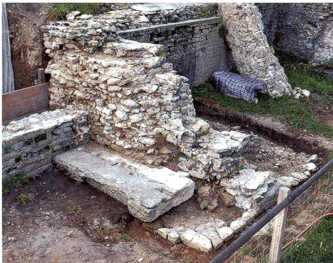
Abb.11 Aventicum/Avenches (VD), römisches Theater. Südwest-Aditus nach Entfernung der schadhafte Zementrestaurierungen. Erkennbar ist das Kernmauerwerk von M93, das in der Antike eine heute fast vollständig verschwundene Verblendung aus Muschelkalksandsteinquadern aufwies. Blick von Norden.
