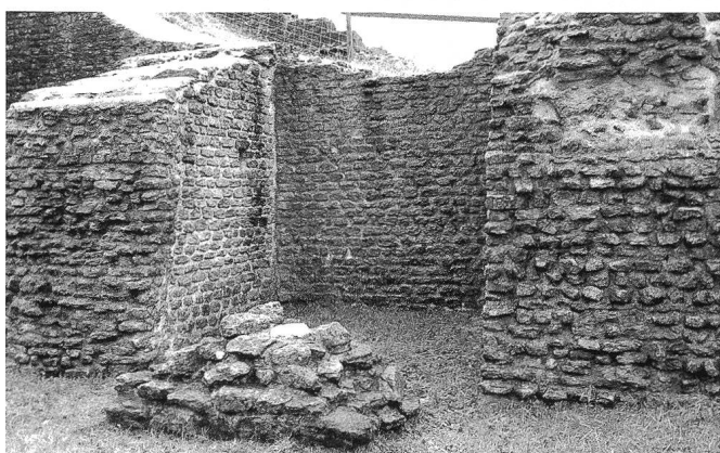
Abb. 5 Aventicum/Avenches (VD), römisches Theater. Mauerzahn M88 in der westlichen Eingangshalle, allmählicher Zerfall des ungeschützt belassenen Mauerstücks im Zeitraum von der Freilegung um 1940 bis zur vollständigen Zerstörung um 1950. Blick von Westen.
