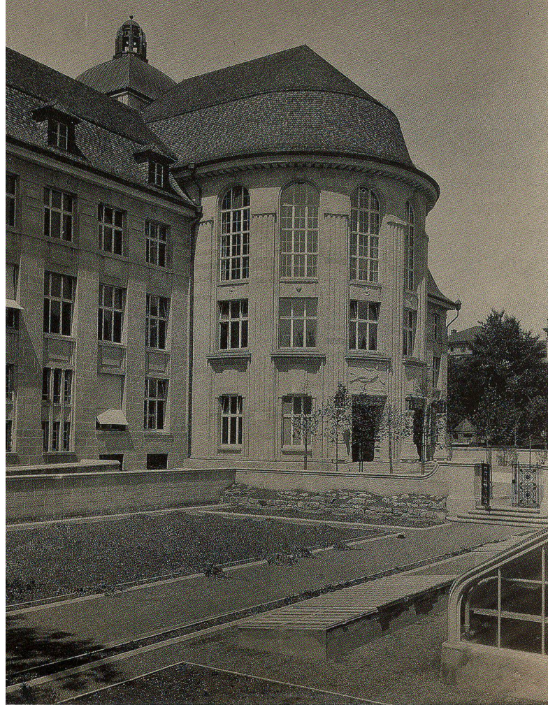
Abb. 8 Osteingang der Universität Zürich mit Walmdach wie bei der zentralen Rotunde der Stiftskirche St.Gallen, gta Archiv/ETH Zürich, 33-1908-01-FX-140.
