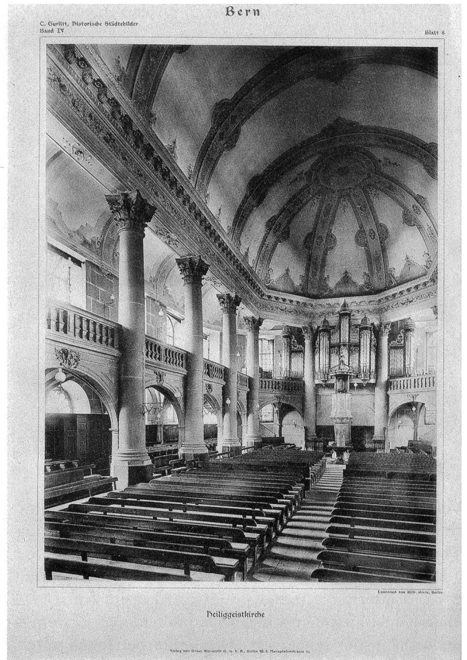
Abb.26 Muldengewölbe der Berner Heiliggeistkirche, aus: CORNELIUS GURLITT, Historische Städtebilder , Bd. 4: Bern–Zürich, Berlin 1903, Exemplar mit Stempel «Curjel & Moser Architekten Karlsruhe», gta Archiv/ETH Zürich, 33-BIB 174 fol.
