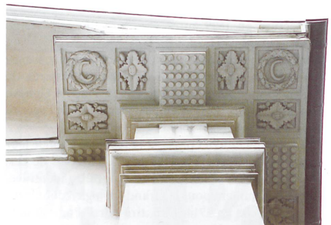
Fig. 12 Plat inférieur d'un tailloir d'angle de l'ancienne maison Calandrini à Frontenex.
