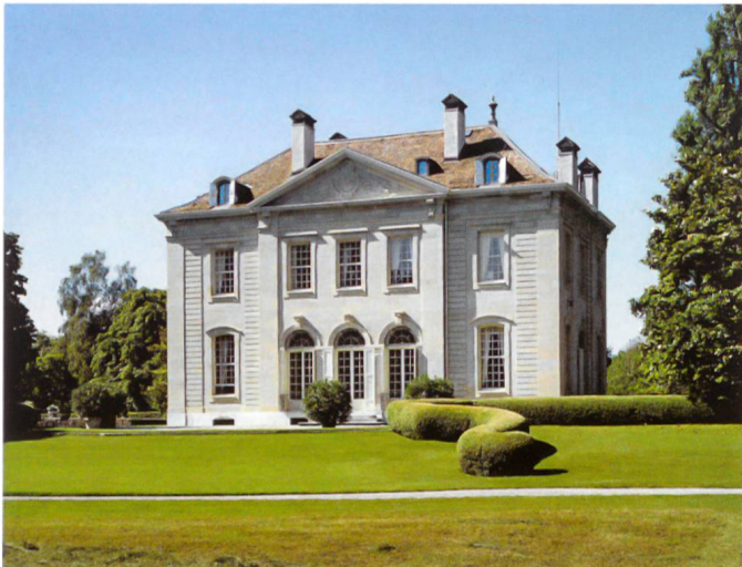
Fig. 9 La maison de maître du Creux-de-Genthod en construction en 1724–1725, d'après un projet de l'architecte parisien Jean-François Blondel.
