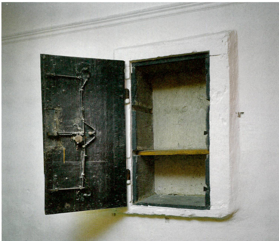
Abb.17 Eingemauerter Tresor mit Hausteinfassung und schmiedeeiserner Tür in der westlichen Wand des ursprünglich bemalten Repräsentations- saales.
