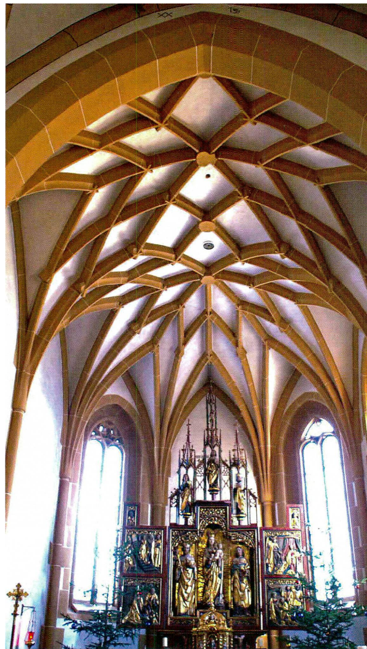
Abb.22 Stürvis, Rauten-Netzgewölbe im Chor.
