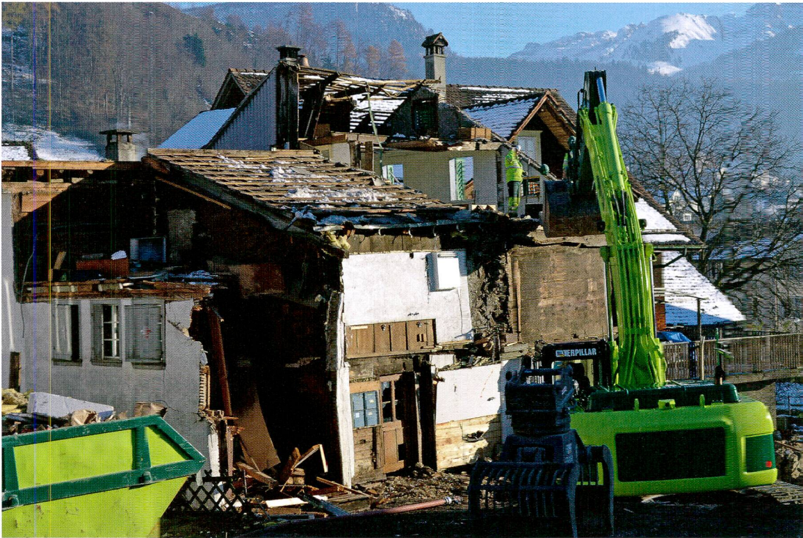
Abb.41 Haus Gütschweg 11. Abbruch am 10. Dezember 2013. Blick gegen Südosten.
