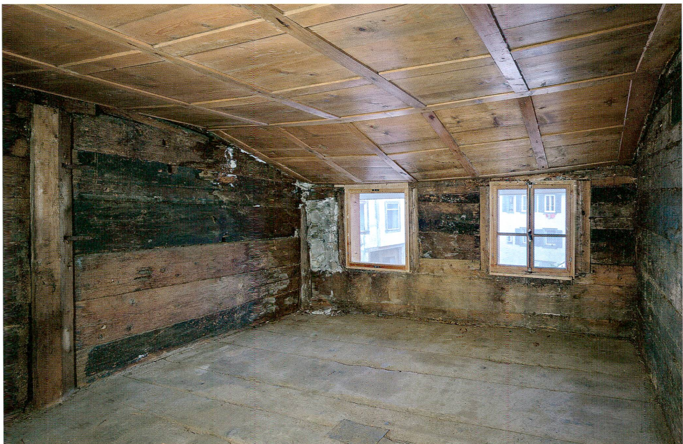
Abb. 40 Haus Gütschweg 11. Nordostanbau (R. 2.12). Blick gegen Nordosten. Balken-Ständer-Bau.
