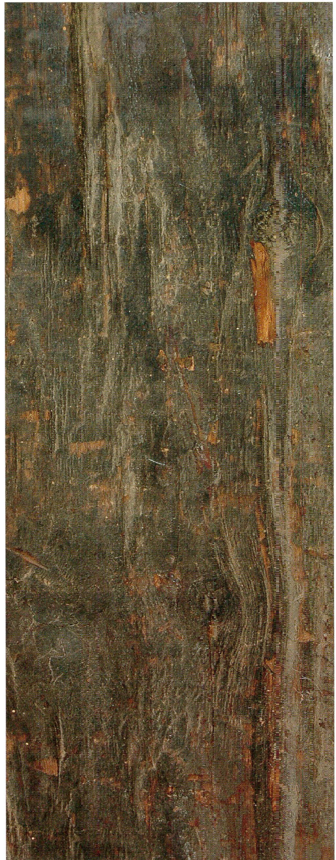
Abb.4 Erscheinungsbild der gealterten, schwarz gestrichenen Oberfläche einer geborgenen Bohle aus dem Dorfbachquartier. Nördlicher Teil der Westfassade, Gütschweg 11/13.
