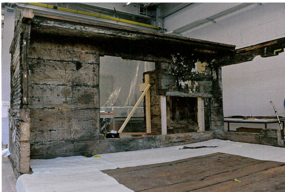
Abb. 5 Wand B mit der ersten Deckenbohle und Deckenbalken.
