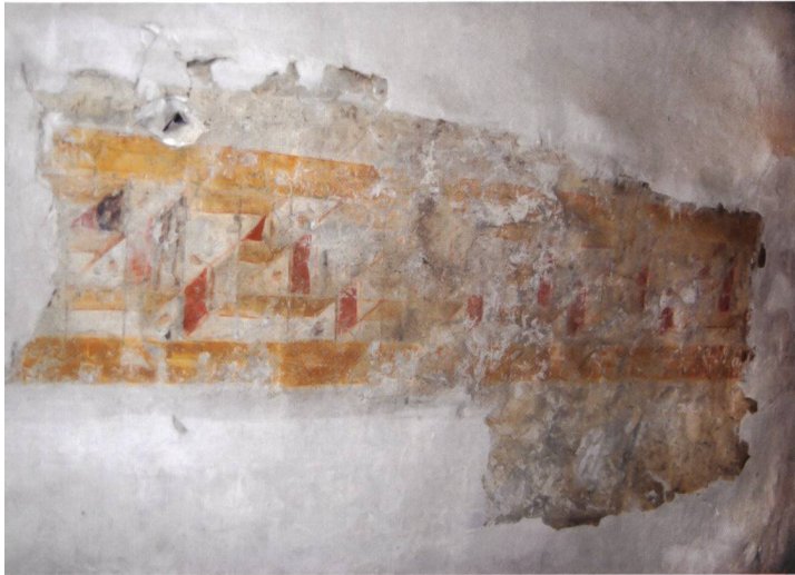
Abb.11 Mäander [13] aus der Bauzeit von Bischof Tietmar zwischen 1040 und 1070. Münstair, Westtrakt, Treppenschacht 146, gegen Südosten.
