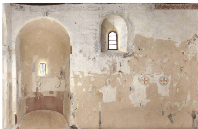
Abb. 5 Südwand, Zustand Juli 2016.
