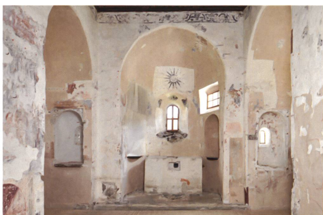
Abb. 4 Blick Richtung Ost, Zustand Juli 2016.
