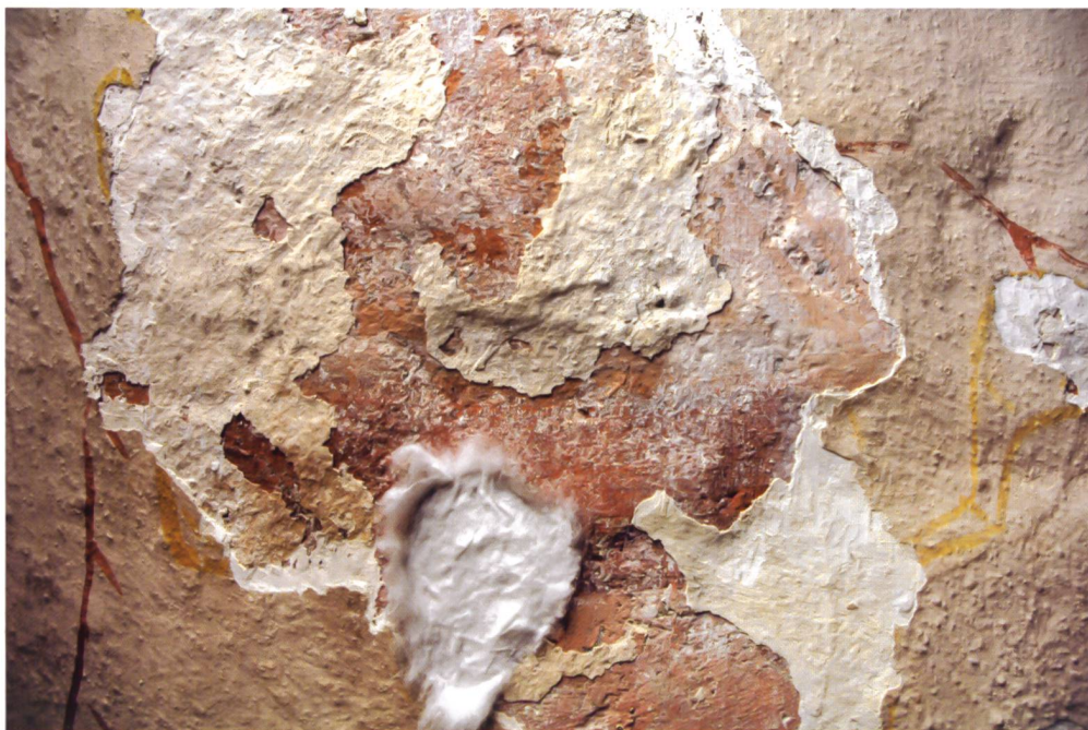
Abb. 15 Abnahme der Deckschichten mittels Kompressenaufgabe.
