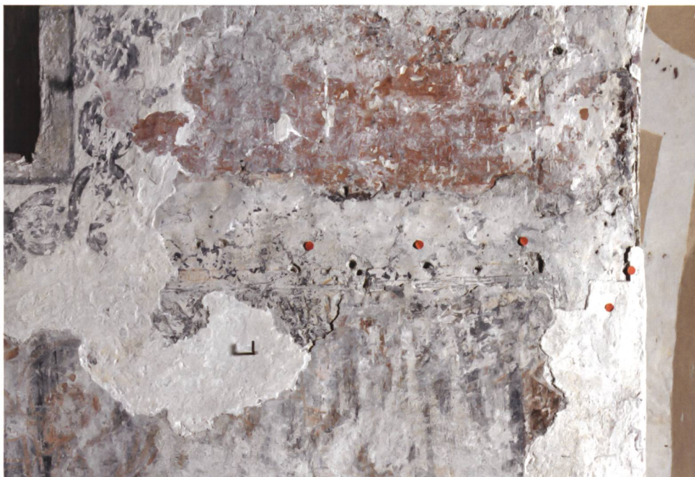
Abb.19 Nordwand, Bereich der Stuckapplikation mit gut erkennbarem Schnurschlag.
