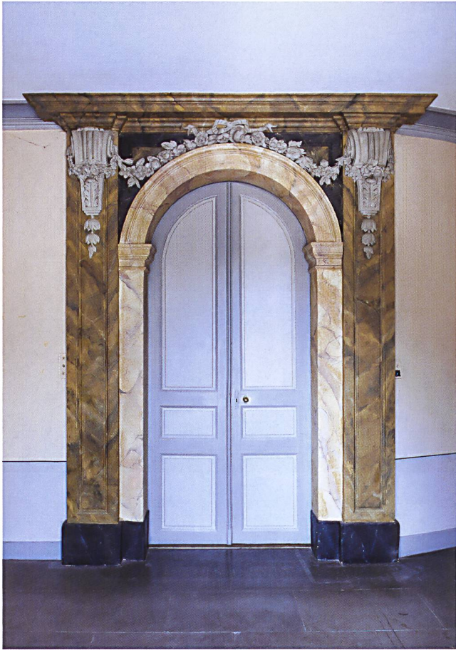
Fig. 12 Hauteville, château. Détail de la porte d'entrée au grand salon, par François Riol, 1766.
