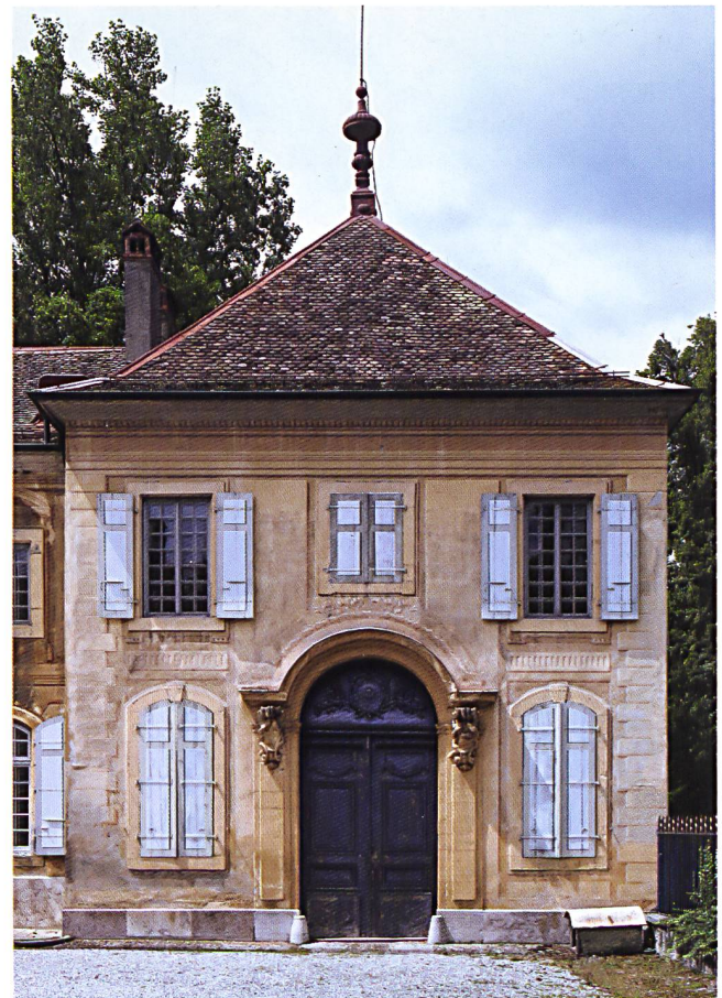
Fig. 11 Hauteville, château. Façade de la remise. Consoles sculptées par François Riol et vantaux confectionnés par David Schade, 1766.
