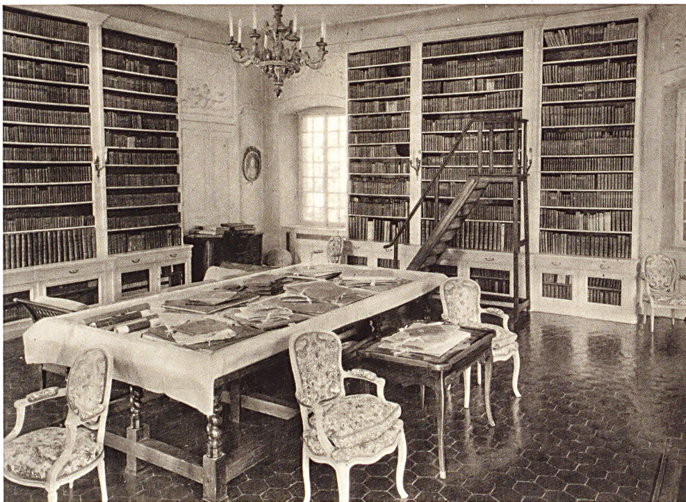
Fig.16 Hauteville, château. Vue de la bibliothèque, état publié en 1932.
