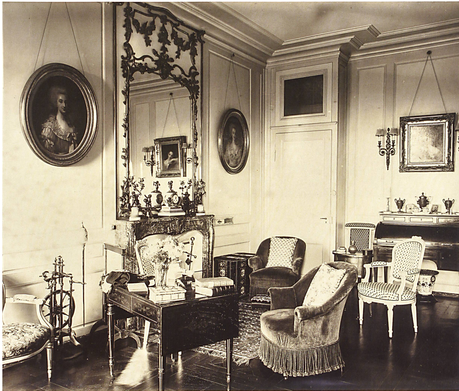
Fig. 12 Hauteville, château. Vue du salon d'hiver, vers 1900. Archives cantonales vaudoises, PP 410/159.
