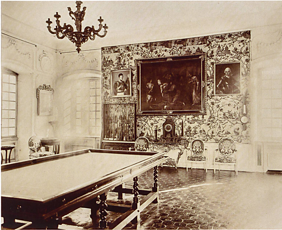
Fig.15 Hauteville, château. Vue du billard, vers 1900. Archives cantonales vaudoises, PP 410/159.
