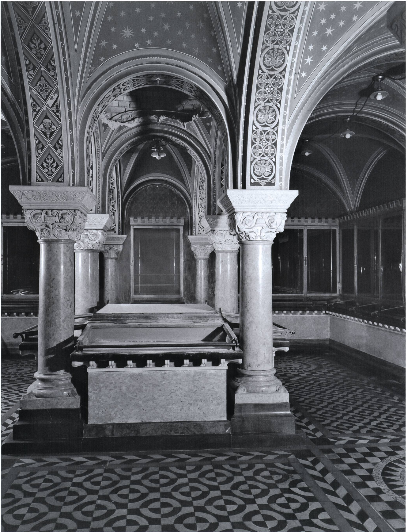
Abb. 2 Blick in die sogenannte Schatzkammer . Zustand vor dem Ausbau. Fotografie von 1939.
