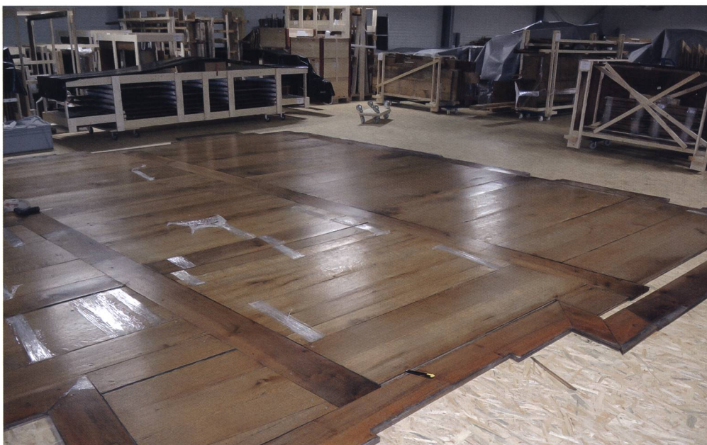
Abb. 34 Boden aus der Seidenhof-Stube, der im Zuge der Restaurierungsmaßnahmen und als Vorbereitung für den Wiedereinbau im Pavillon im Sammlungszentrum ausgelegt worden ist. Sammlungszentrum, Affoltern am Albis.
