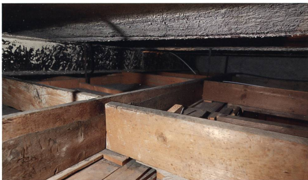
Abb. 40 Blick auf die Unterkonstruktion einer Decke, mit nur wenig Abstand zu den darüber liegenden Stahlträgern. Zu sehen sind die Überblattung der Balken sowie Schiftungen und Verkeilungen der Elemente. Pestalozza-Stube, Landesmuseum Zürich.
