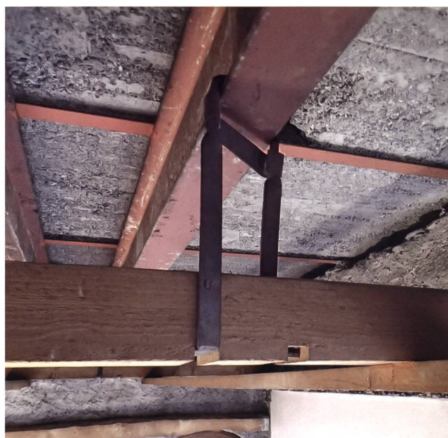
Abb. 17 Befestigung der tragenden Balken der Unterkonstruktion mit Metallbändern an den Stahlträgern. Wiggen-Stube, Landesmuseum Zürich.
