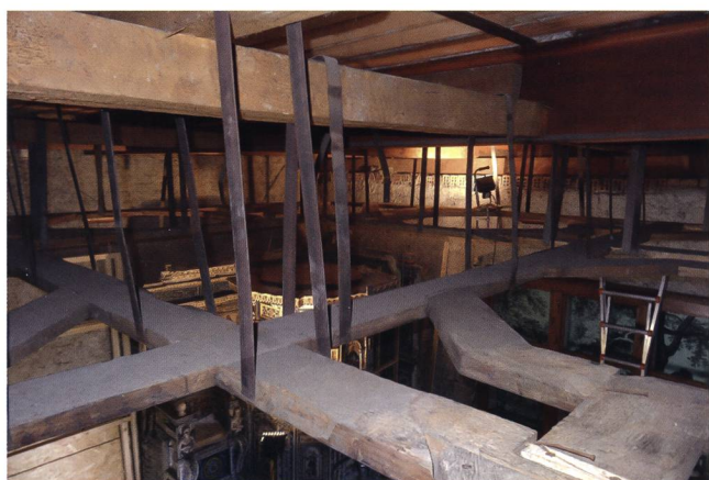
Abb. 15 Befestigung von Deckenelementen mithilfe gebogener Metallbänder. Seidenhof-Stube, Landesmuseum Zürich.
