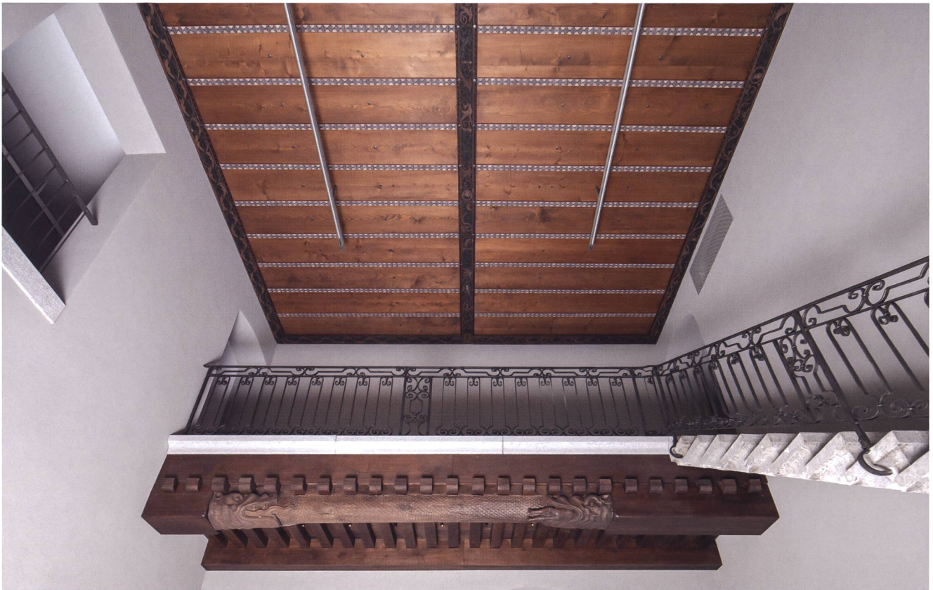
Abb. 35 Teilrekonstruierte Decken nach dem Wiedereinbau im Lichthof des Landesmuseums. Decke aus dem Schloss Neunkirch (oben) und dem Schloss Promenthoux (unten), Landesmuseum Zürich.
