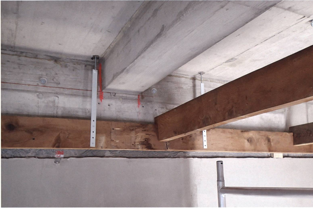
Abb. 33 Die Rahmenbalken der Unterkonstruktion wurden mithilfe von Bankeisen direkt in der Betondecke verankert. Decke aus der Kirche Windisch, Landesmuseum Zürich.
