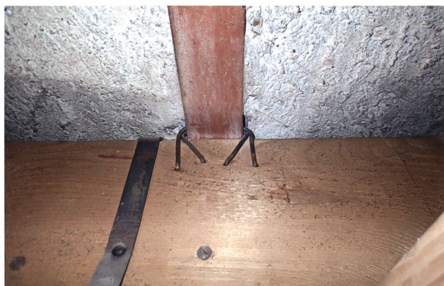
Abb. 16 Fixierung der Unterkonstruktion mit Metalldrähten an den Stahlträgern der originalen Betondecke. Decke aus dem Haus zum Venedigli, Landesmuseum Zürich.
