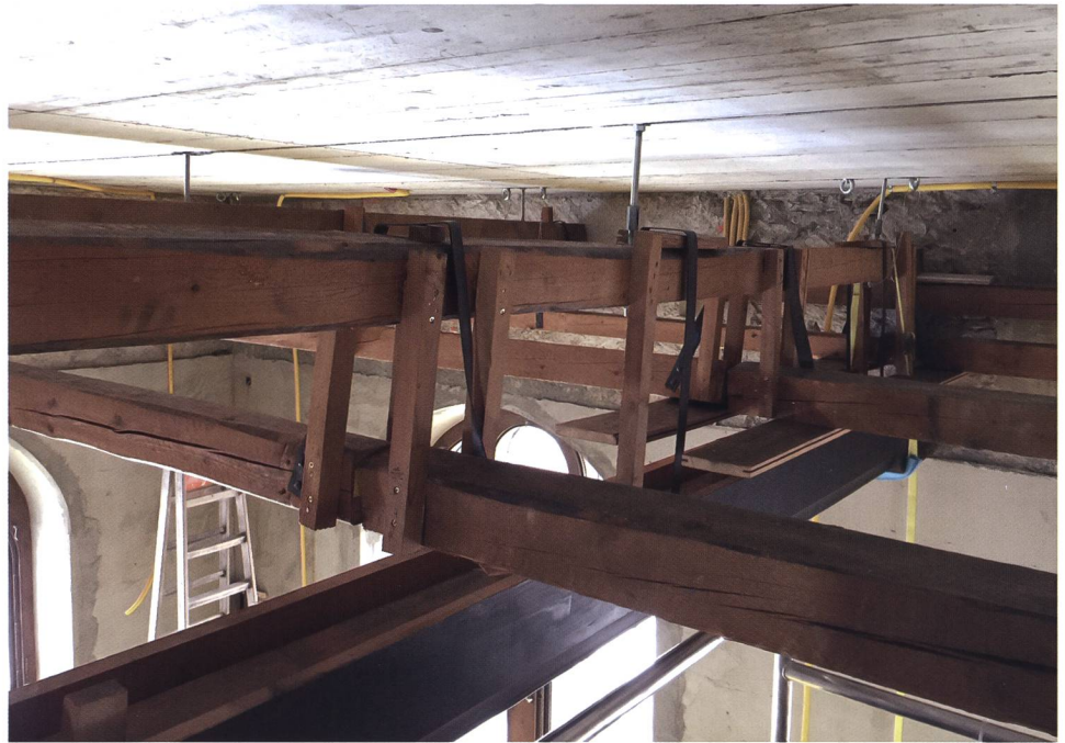
Abb. 32 Deckenunterkonstruktion, die an neuen Halfenschienen an der Betondecke montiert ist. Die Unterkonstruktion ist in sich mit den originalen Metallschlaufen verbunden. Decke aus dem Schloss Arbon, Landesmuseum Zürich.
