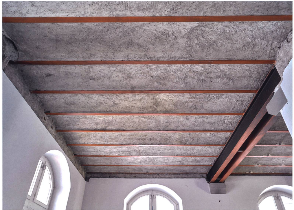
Abb. 28 Originale Betondecke mit Stahlträgern von 1898 nach dem Ausbau der Holzdecke aus dem Haus zur Goldenen Gilge, Zürich. Raum Korridor 00.102.H, Landesmuseum Zürich.
