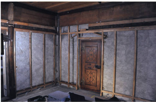
Abb. 12 Aufwendig ausgeführte Rahmenkonstruktion für die Montage der Täferwand. Oetenbach-Stube, Landesmuseum Zürich.
