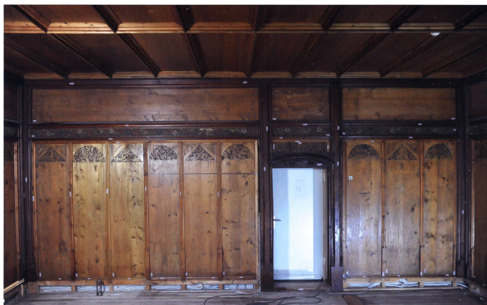
Abb. 1 Vor dem Ausbau der Wand- und Deckenverkleidung, 2016. Oetenbach-Stube, Landesmuseum Zürich.
