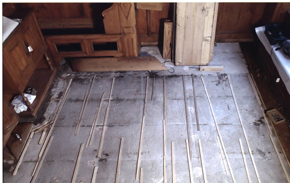
Abb. 22 Lose ausgelegte Leisten und Schifthölzer als Unterlage für die Bodendielen. Wiggen-Stube, Landesmuseum Zürich.
