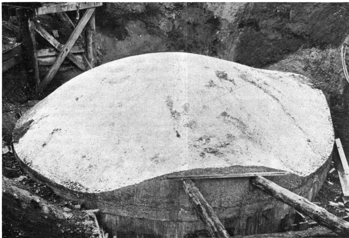
Kuppel des Unterstandes «Schindler» vor dem Eindecken
