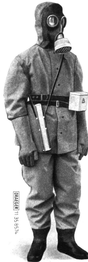
Bild 3. Gasspürer mit Gasspürgerät Draeger-Schröter. Rechercheur de gaz avec détecteur Draeger-Schroeter.
