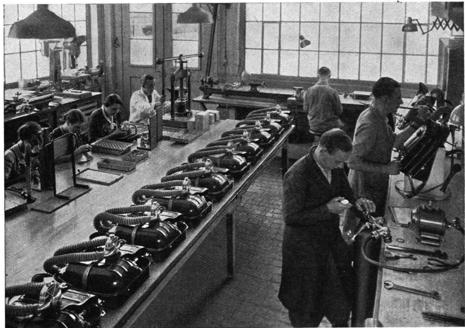
Abb. 2 FEGA-Fabrikation des Sauerstoff-Schutzgerätes Type KG 130 A
