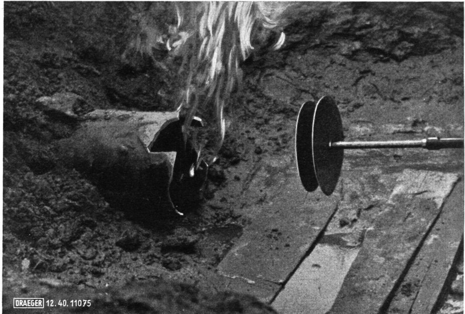
Abb. 2. Einführen einer Doppelblende zum Ablöschen einer brennenden Gasleitung.
