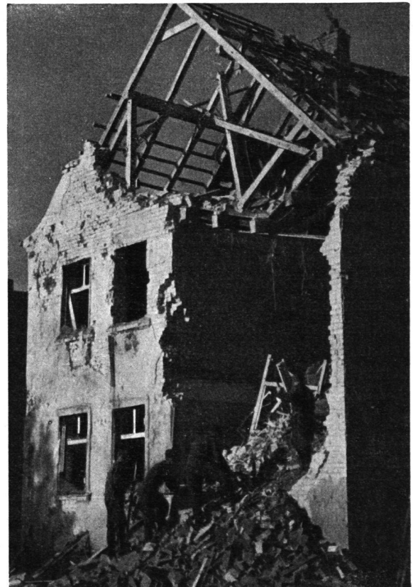
Abb. 19. Sekundäre Trümmerwirkung eines Gebäudes aus Backsteinmauerwerk infolge eines Nahtreffers. Vermutlich genügte die Zerstörung eines Fensterpfeilers in der jetzigen Lücke, um die eine Hälfte des Giebels zum Einsturz zu bringen. Der Schuttkegel steigt in einer geraden Linie nach hinten hoch an: Zuoberst im Schuttkegel liegen die Möbel des ersten Stockes. Das Gebälk, das auf der Vorderfassade sein Auflager verloren hat, liegt noch auf der hintern Quermauer auf. Das Dachgebälk rutscht in die Lücke nach und hängt noch an der Nagelung des Dachbodens. Der Dachstuhl ist mangelhaft konstruiert, der Schub des Dachstuhles wird durch das Gebälk nicht aufgenommen, weil es über dem ersten Stock in falscher Richtung läuft.
