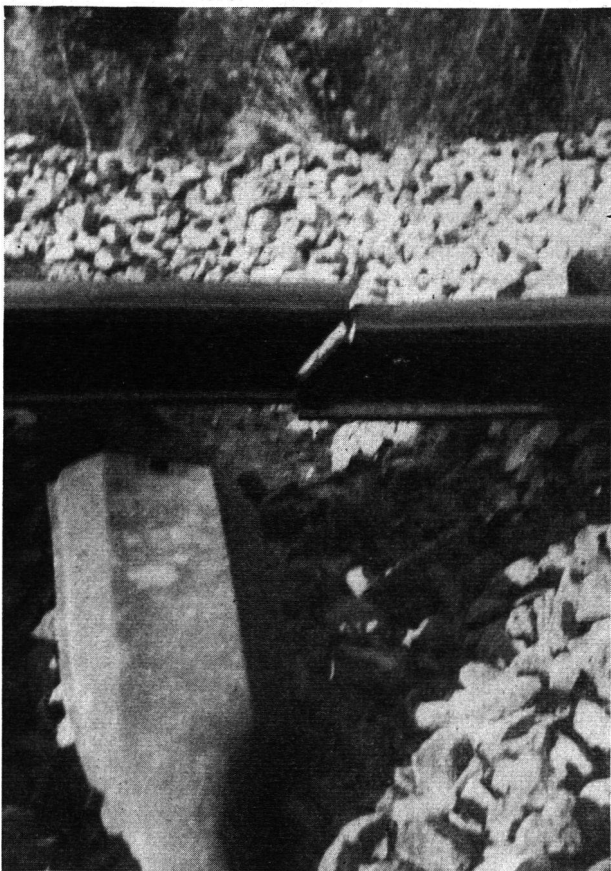
Blindgänger-Aufschlagstelle auf Bahnlinie Seebach—Affoltern; Auswirkungen: Durchschlagene Bahnschiene, deformierte Eisenschwelle, zerrütteter Schotter.
