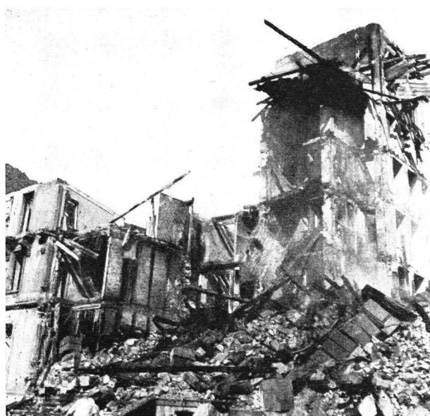
Trümmer nach der Sprengung (Baden)
