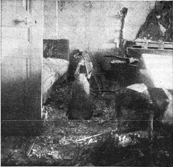
Brandbombe, die im Gebäude zur Explosion gebracht wird (Baden) Bu VI 16813
