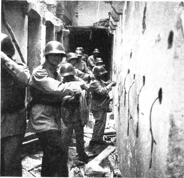
Anlegen der verdämmten Ladungen am Gebäudefuss (Baden)
