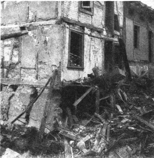
Bild 4. Erschütterung der Mauern durch die Explosionen.
