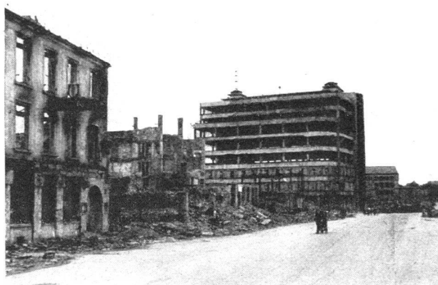
Bauten in Eisenbetonkonstruktion hielten dem Feuer stand, brannten aber im Innern vollständig aus. Die beiden untersten Stockwerke wurden provisorisch wieder ausgebaut (Stuttgart).
