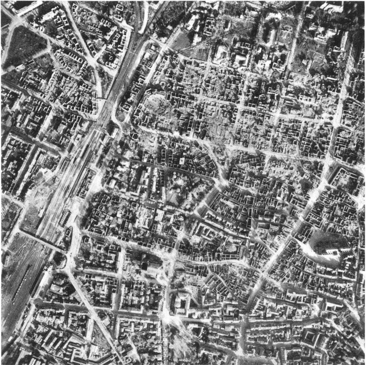
Abb. 4. Bild des zerstörten Teils Freiburgs aus dem Flugzeug. Man erkennt, dass das Münster und einige Gebäude südlich davon nicht wesentlich Schaden genommen haben.
