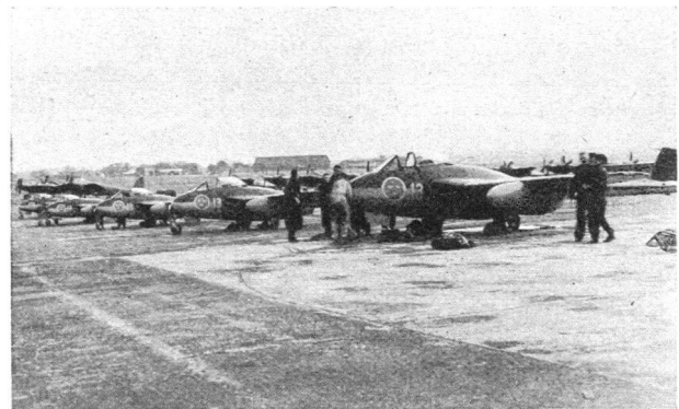
Abb. 3. Fünf für die schwedische Luftwaffe abgelieferungsbereite «Vampir»-Rückstossjäger auf dem Werftflugplatz von Hatfield. Nahe am Rumpf dieser Düsenjäger (bei der Zahl 13) sind die Eintrittsöffnungen (linksseitige) für die zum Antrieb benötigten riesigen Mengen an Aussenluft sichtbar.
