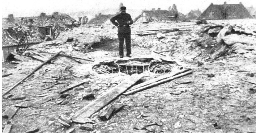
Abb. 6. Essen, Luftschutzhochbunker, Baujahr 1943. Wandstärke 1,10 m, Deckenstärke 1,40 m. Spiralbewehrung mit zusätzlichen statischen Betonstählen in der Zugzone. Bombengewicht 2000–3000 kg. Die Decke zeigt oben ein rundes Loch von etwa 2,60 m Ø. An der Unterseite der Decke ist das Loch bis 4,00 m gross. 21 Gefallene und etwa 100 Verwundete.
