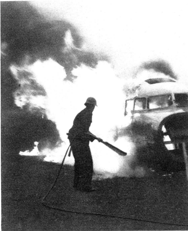
Einsatz mit Kohlensäure-Schnee-Gas, was den Brand von der Führerkabine zurückhält.
