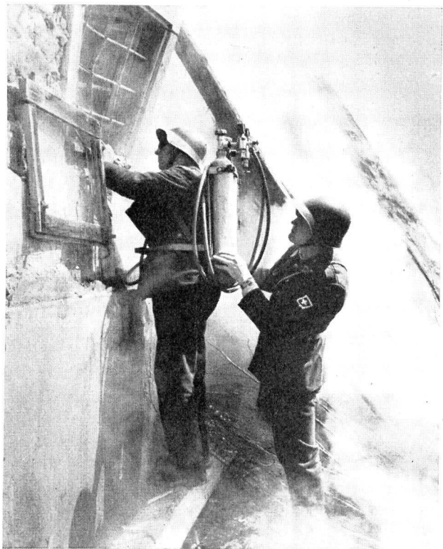
Arbeit mit dem Schneidbrenner bei den Stallungen des Hotels «Drei Könige»
