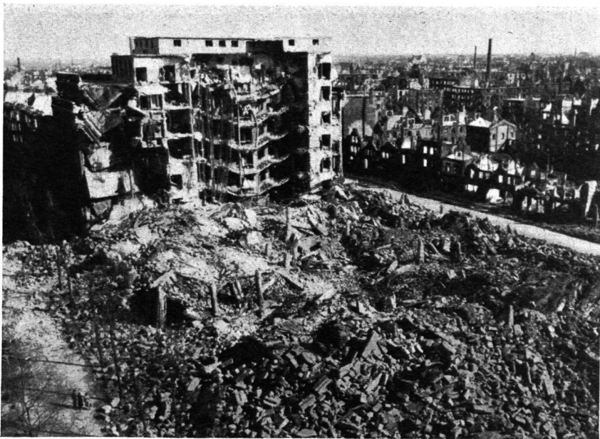
Abb. 5. Das ausgebrannte und zusammengestürzte grösste und modernste Hamburger Warenhaus «Karstadt» im Stadtteil Barmbeck nach dem Luftangriff vom 28./29. Juli 1943. Es steht in einem Flächenbrandgebiet von 5,8 Quadratkilometern Ausdehnung.
