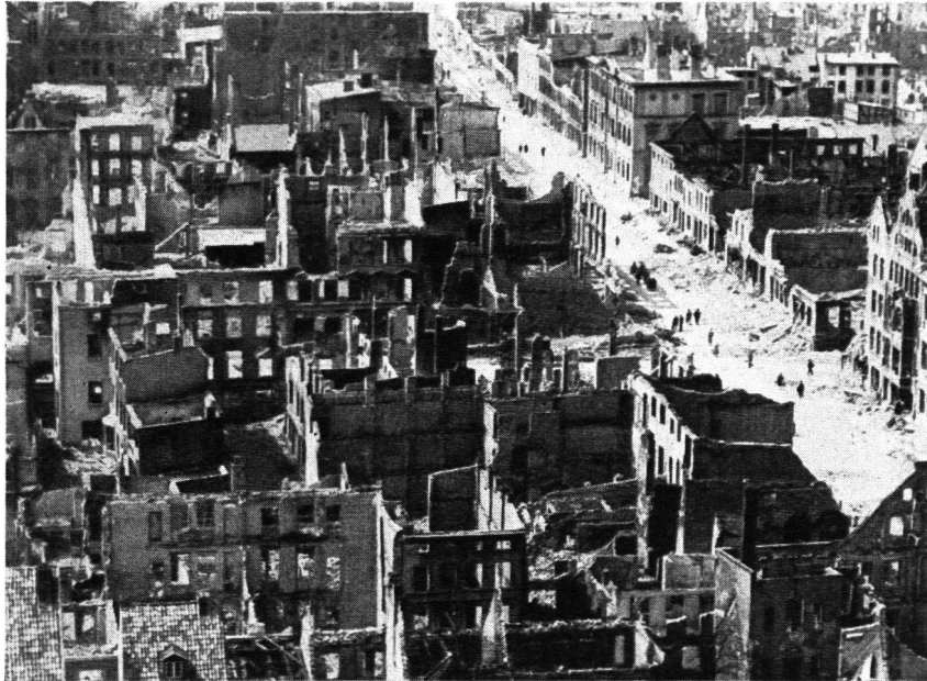
Abb. 1. Flächenbrandgebiet in Rostock (vorwiegend Altstadtbauweise)
