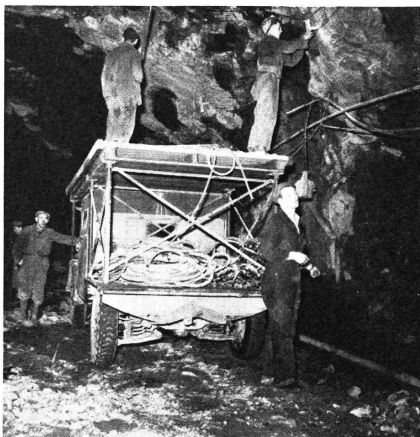
Unter der alten Festung Akershus, die einst die Anlage der norwegischen Hauptstadt bestimmte, sind Mineure seit Monaten an der Arbeit, um gewaltige unterirdische Hallen in die Felsmassen zu sprengen. Unser Bild zeigt eine Mineurgruppe bei der Placierung der Sprengladungen in einem der Eingangsstollen.
