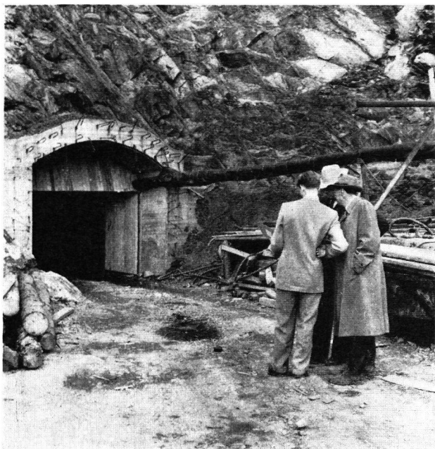
Das ist einer der drei Eingänge des Luftschutzraumes Maridalsveien 14, der 4500 Menschen aufnehmen kann. Die Gemeinde Oslo hat ein besonderes Amt geschaffen, das sich den Fragen der Zivilverteidigung widmet. Rechts im Bilde orientiert sich der Zivilverteidigungs-Konsulent der Gemeinde Oslo über den Fortschritt der Luftschutzbauten.
