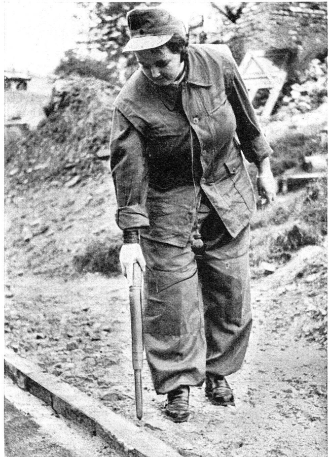
Die Arbeit mit dem Geigerzähler gehört zur praktischen In-struktion dieser Kurse. Dieses Modell gibt akustische Signale, während andere mit Zeigerausschlag optisch reagieren.
