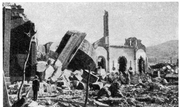
Abb. 8. Eingestürzte Kirche in Nagasaki in 550 m Abstand vom Schadenzentrum.
