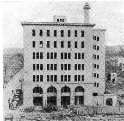
Abb. 7. Erdbebensichere Betonkonstruktion in etwa 300 m Abstand vom Zentrum in Hiroshima; erscheint äußerlich unbeschädigt, ist aber inwendig ausgebrannt.
