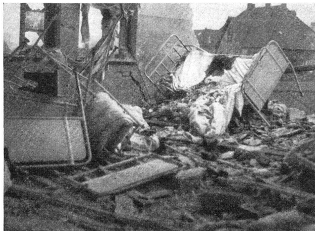
Ein Krankenhaus nach der Zerstörung
