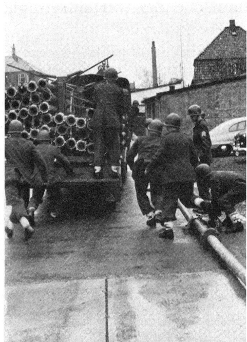
Die auf Spezialwagen mitgeführten Schnellkuppelungsrohre sind ein wertvoller Bestandteil der Ausrüstung. Von einer gut ausgebildeten Truppe können in sieben Minuten 420 m verlegt und an das Wasser angeschlossen werden.
